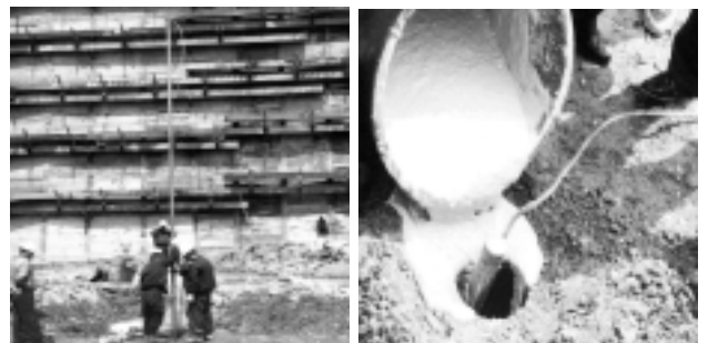
그림. 2-9 XIT 전해질 접지붕 시공사진
