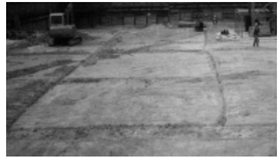
그림. 2-8 메시 접지 시공 사진
